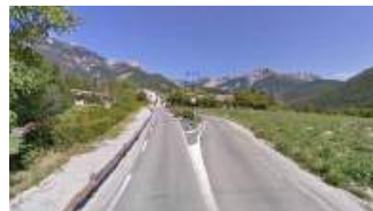
Ilot central en entrée de village
