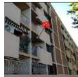
Mesure de bruit avant/après pose d'un enrobé acoustique
